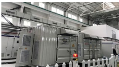
ภาพแสดงอุปกรณ์ควบคุมระบบไฟฟ้าอัจฉริยะ (Microgrid Controller) โครงการพัฒนาระบบไฟฟ้าแบบโครงข่ายไฟฟ้าขนาดเล็กมาก (Microgrid) อ.แม่สะเรียง จ.แม่ฮ่องสอน วงการไฟฟ้าส่วนภูมิภาค
