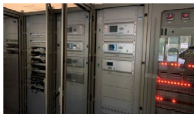
ภาพแสดงอุปกรณ์ควบคุมระบบไฟฟ้าอัจฉริยะ (Microgrid Controller) โครงการพัฒนาระบบไฟฟ้าแบบโครงข่ายไฟฟ้าขนาดเล็กมาก (Microgrid) อ.แม่สะเรียง จ.แม่ฮ่องสอน วงการไฟฟ้าส่วนภูมิภาค
